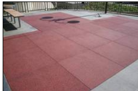
3 ricopertura finale con le piastrelle da cm.98x98
