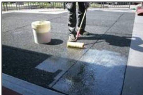
2 stesura del collante monocomponente
