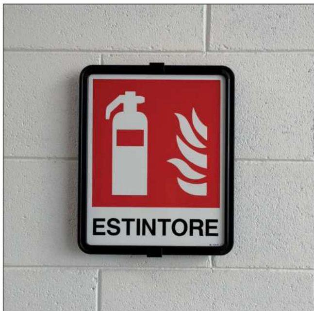
INSTALLAZIONE DI SEGNALI MONOFACCIALI
