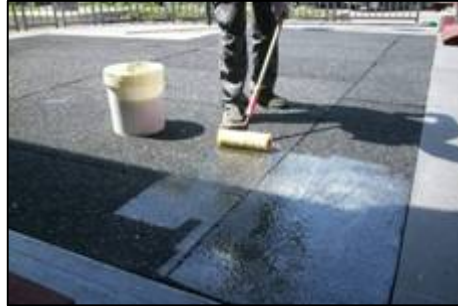
2 stesura del collante monocomponente
