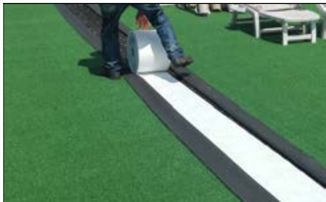
nastro per la giunzione dei rotoli di erba
